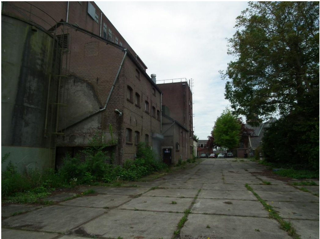
Figuur 5 De niet bebouwde grond van de planlocatie is verhard. Tussen de stelconplaten staat opschot van algemene kruiden
