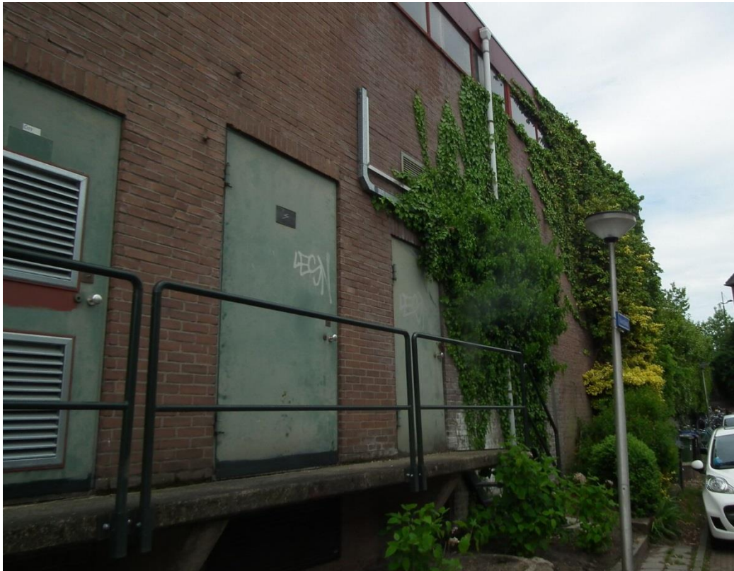
Figuur 6 De voormalige meelfabriek grenst aan de achterzijde aan de Vaarsloot.
