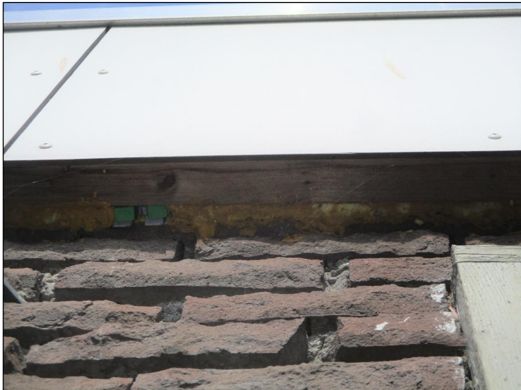
Figuur 5 De dakranden zijn afgedicht met porschuim, waardoor aanwezigheid van gebouwbewonende vleermuizen uitgesloten kan worden.
