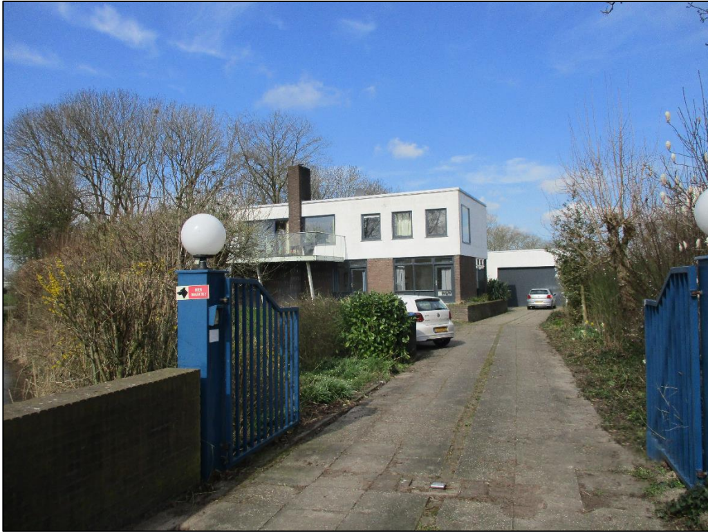
Figuur 1 De planlocatie is gelegen aan de Zijl 2 te Vuren en betreft een vrijstaande woning met een aantal bijgebouwen. Een deel van de bebouwing zal gesaneerd worden om de realisatie van 2 vrijstaande woningen mogelijk te maken.
