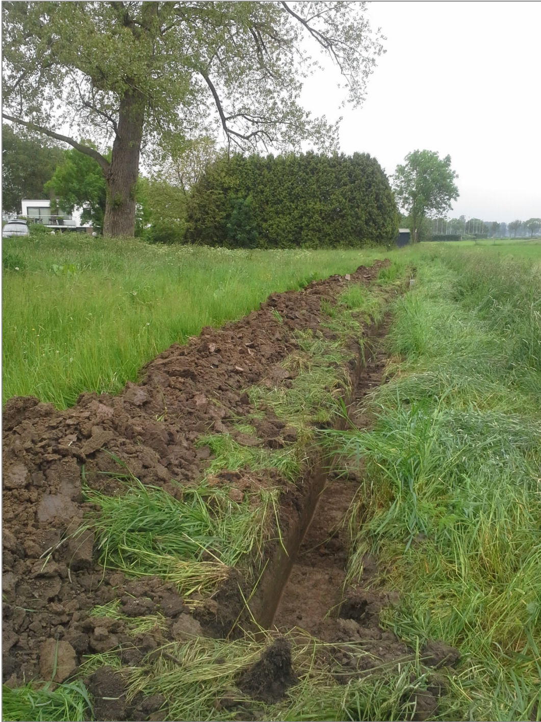
Afb. 7 Foto van de recent gegraven kabelsleuf in het plangebied
