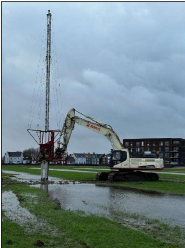
Foto 17 Uitvoeren dieptedetectie
