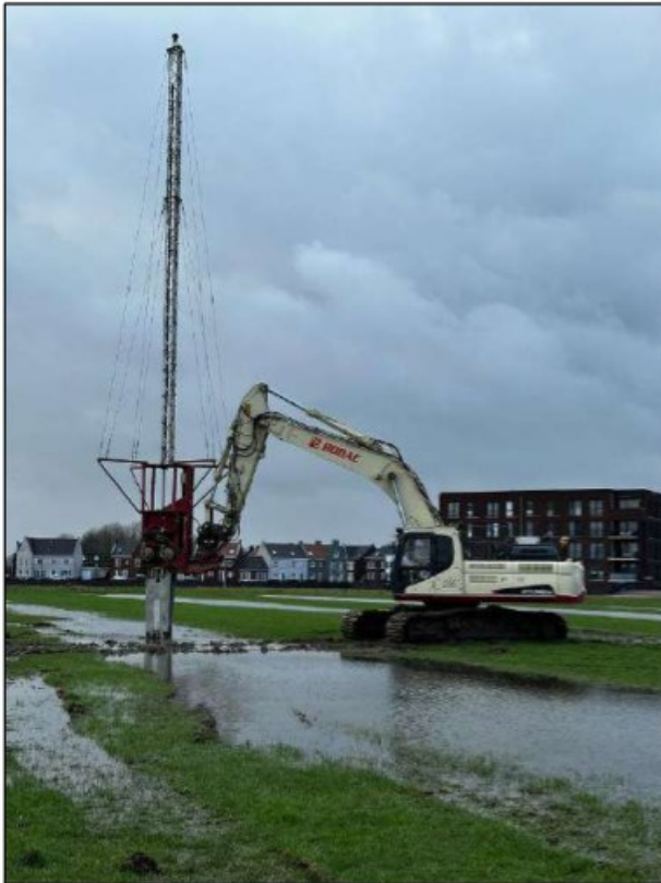
Foto 19 Uitvoeren dieptedetectie
