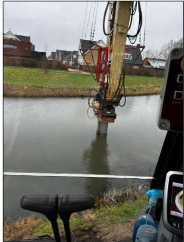
Foto 20 Uitvoeren dieptedetectie in watergang
