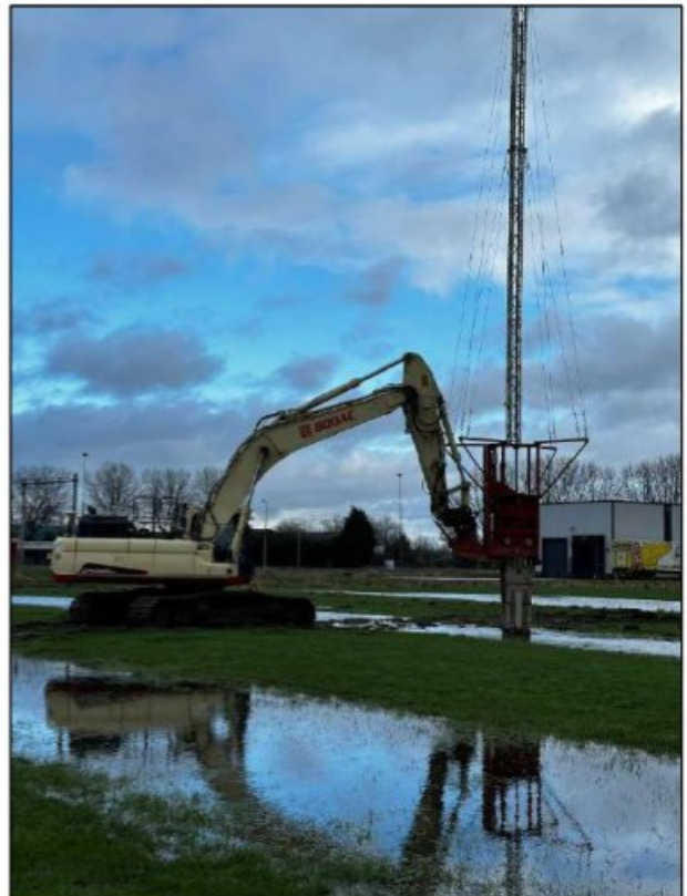
Foto 18 Uitvoeren dieptedetectie
