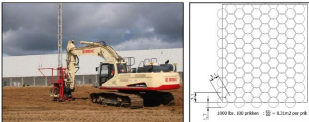
Figuur 11. Passieve realtime dieptedetectie m.b.v. MDE-drive en een voorbeeld prikraster voor vlak dekkende dieptedetectie waarbij het kleinste OO 1.000 lb. bedraagt.
