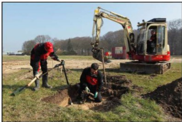
Figuur 12. Benaderen van een significant object m.b.v. een hydraulische graafmachine.
