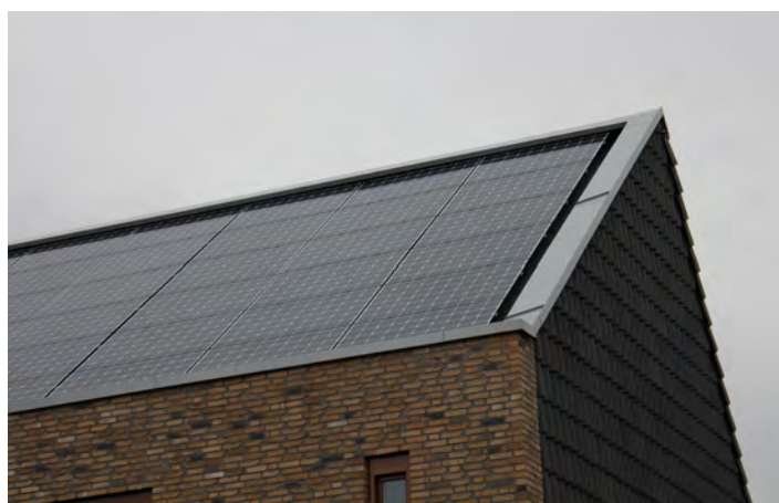
Voorbeeld van een achterdakvlak dat geheel met PV-collectoren is bedekt.
