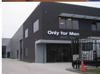
Ingetogen vormgeving reclame-uitingen, in evenwicht met de architectuur
