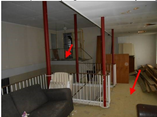
Foto 34 | colovinyltegels en bitumen lijmlaag
