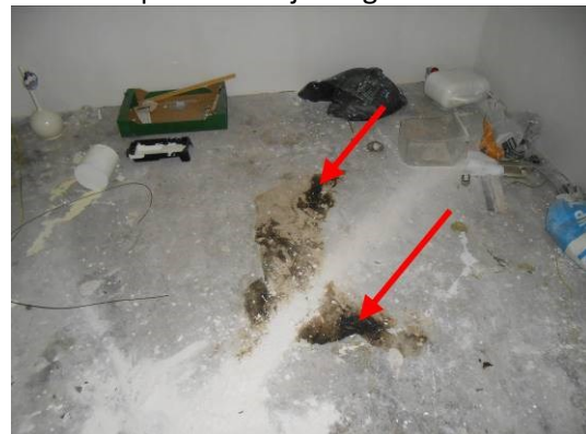
Foto 76 | bitumen lijmlaag in alle ruimtes
