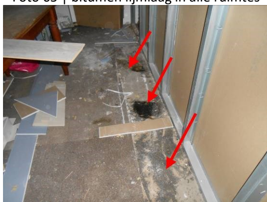
Foto 67 | bitumen lijmlaag in alle ruimtes
