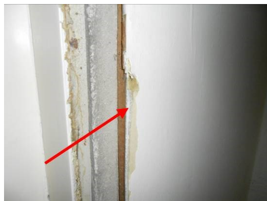
Foto 52 | wandbeplating tegen voorgevel
