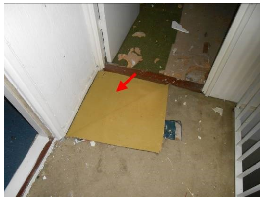
Foto 29 | colovinyltegels en bitumen lijmlaag
