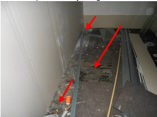
Foto 73 | bitumen lijmlaag in alle ruimtes
