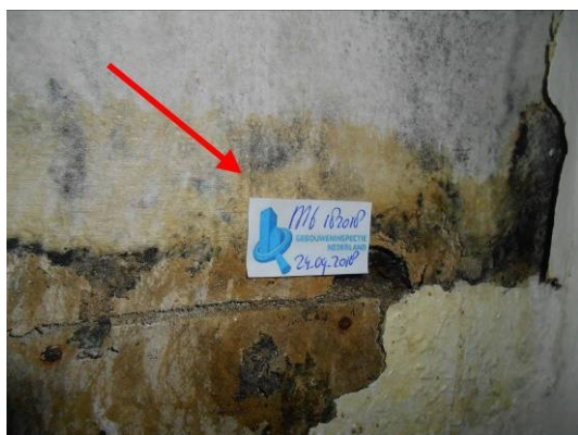
Foto 45 | wandbeplating tegen voor en achtergevel
