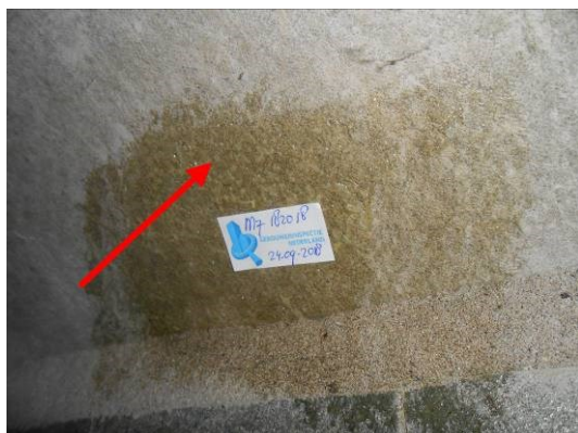
Foto 54 | plaatmateriaal in schouw
