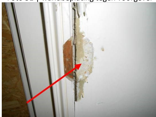
Foto 53 | wandbeplating tegen voorgevel
