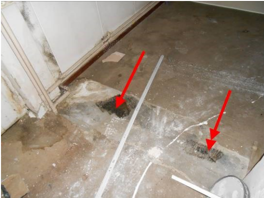
Foto 71 | bitumen lijmlaag in alle ruimtes
