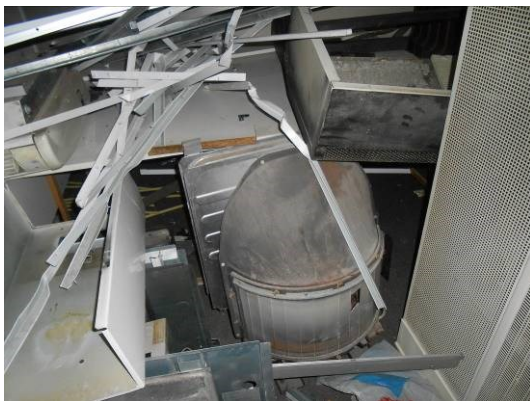
Foto 19 | De overige kachels zijn niet asbestverdacht
