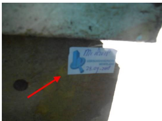
Foto 1 | vlakke plaat tegen onderkant overstek keuken nr.46
