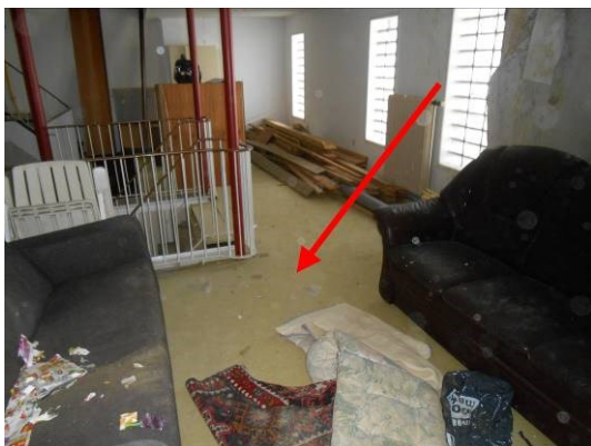
Foto 28 | colovinyltegels en bitumen lijmlaag
