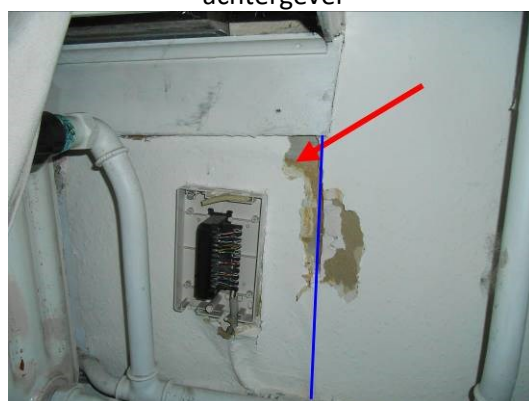
Foto 48 | wandbeplating tegen voor en achtergevel
