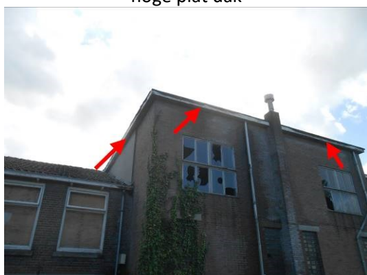
Foto 7 | vlakke plaat tegen onderkant overstek hoge plat dak
