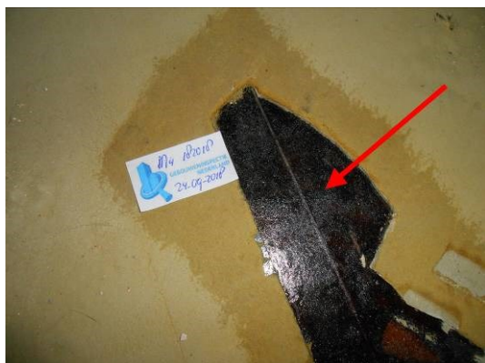
Foto 24 | colovinyltegels en bitumen lijmlaag
