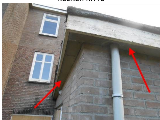
Foto 3 | vlakke plaat tegen onderkant overstek keuken nr.46
