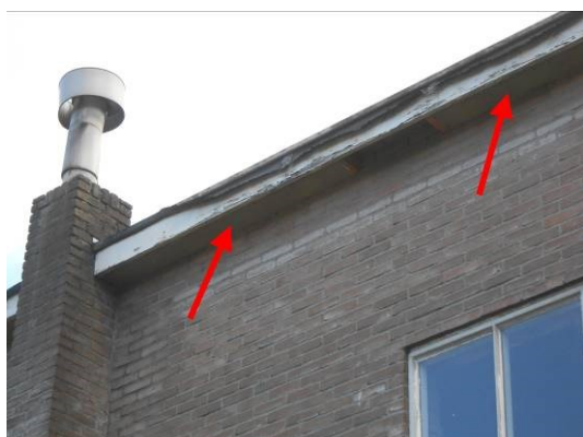
Foto 5 | vlakke plaat tegen onderkant overstek hoge plat dak
