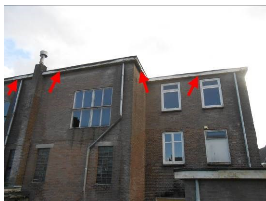
Foto 6 | vlakke plaat tegen onderkant overstek hoge plat dak
