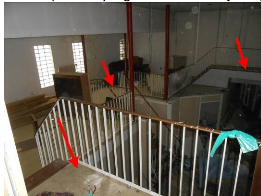
Foto 33 | colovinyltegels en bitumen lijmlaag
