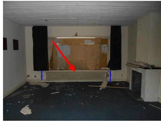
Foto 50 | wandbeplating tegen voor en achtergevel
