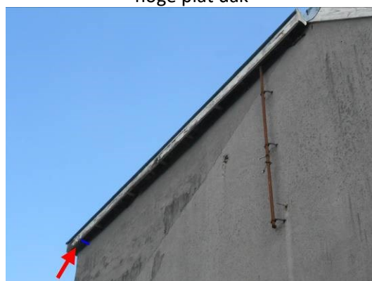
Foto 8 | vlakke plaat tegen onderkant overstek hoge plat dak
