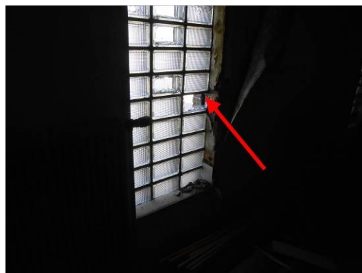
Foto 36 | bitumen tussen glazen bouwstenen achtergevel nr.48
