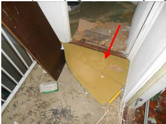
Foto 32 | colovinyltegels en bitumen lijmlaag
