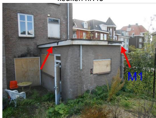
Foto 4 | vlakke plaat tegen onderkant overstek keuken nr.46
