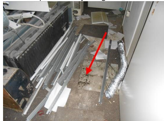
Foto 74 | bitumen lijmlaag in alle ruimtes
