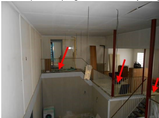
Foto 30 | colovinyltegels en bitumen lijmlaag
