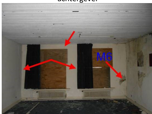
Foto 47 | wandbeplating tegen voor en achtergevel
