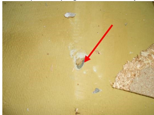
Foto 31 | colovinyltegels en bitumen lijmlaag
