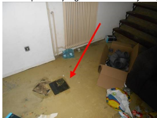
Foto 27 | colovinyltegels en bitumen lijmlaag
