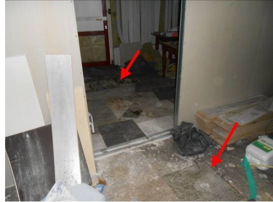
Foto 70 | bitumen lijmlaag in alle ruimtes
