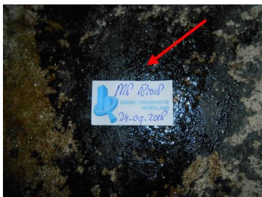
Foto 65 | bitumen lijmlaag in alle ruimtes
