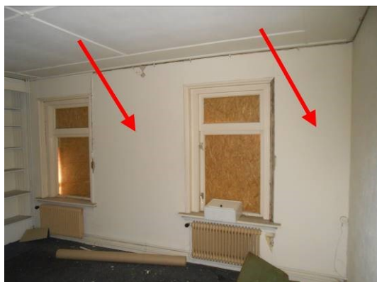
Foto 51 | wandbeplating tegen voorgevel
