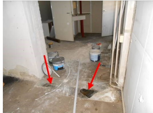
Foto 72 | bitumen lijmlaag in alle ruimtes
