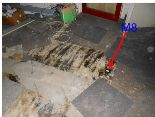
Foto 66 | bitumen lijmlaag in alle ruimtes
