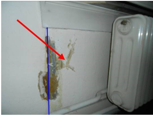
Foto 49 | wandbeplating tegen voor en achtergevel
