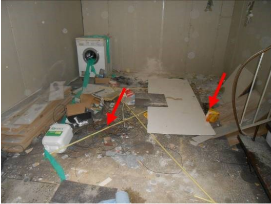
Foto 69 | bitumen lijmlaag in alle ruimtes
