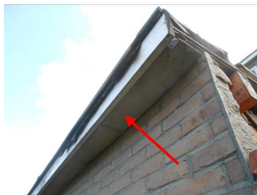
Foto 2 | vlakke plaat tegen onderkant overstek keuken nr.46
