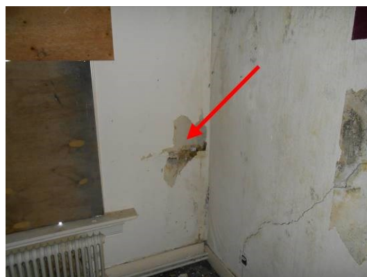
Foto 46 | wandbeplating tegen voor en achtergevel
