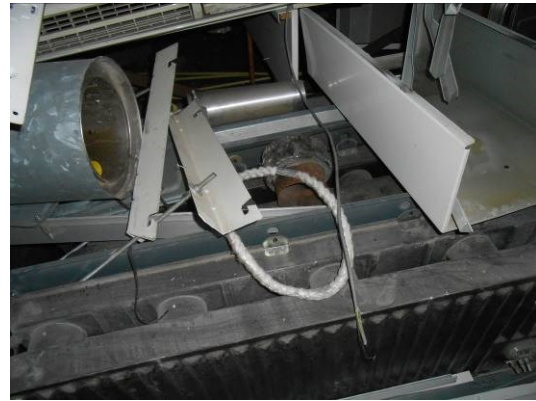
Foto 18 | De overige kachels zijn niet asbestverdacht.
