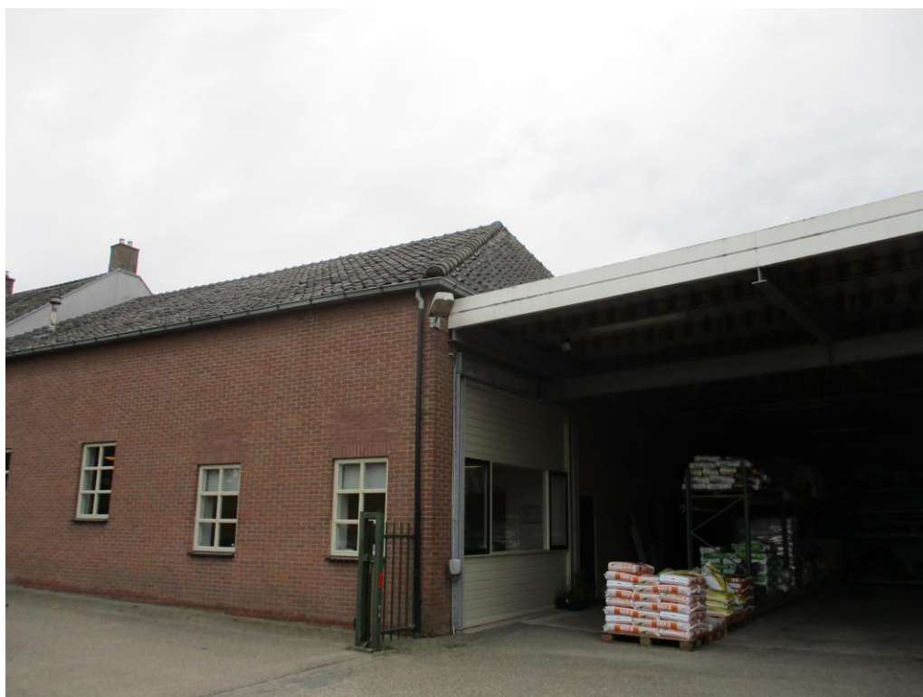
Figuur 2 De aanbouw (B) is opgetrokken uit gemetselde muren met een schuin dak pannendak met daarnaast de aanbouw (C) opgetrokken uit damwandplaten en aan de oostzijde volledig open.
