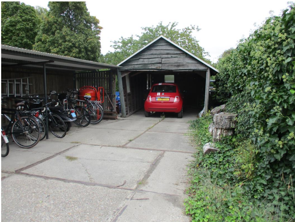
Figuur 4 De overkapping en fietsenschuur (G) opgetrokken uit houten wanden met een golfplaten dak.
