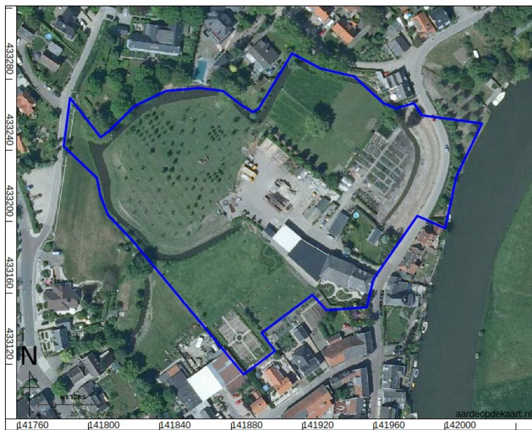
Figuur 40: Luchtfoto uit 2008.
