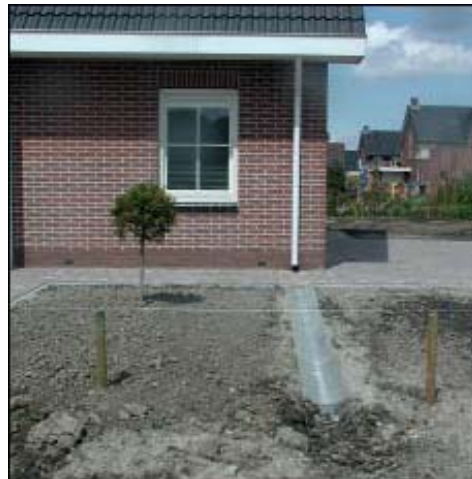
Figuur 6: gootje om hemelwater af te voeren
