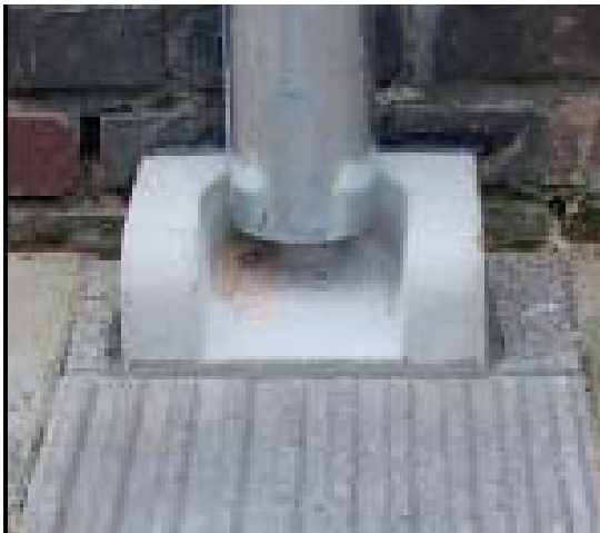
Figuur 5: regenpijp eindigend boven de grond
