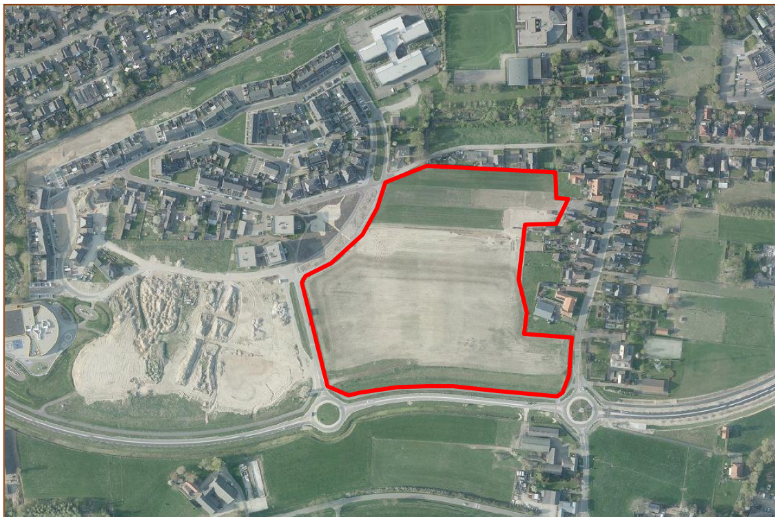
Figuur 2. Luchtfoto van het plangebied (rood), bron: Provincie Gelderland (2016).
