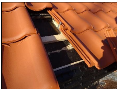
Figuur 20. Voorbeeld plaatsen vogelschroot bij derde rij dakpannen.
