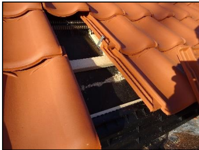
Figuur 21. Voorbeeld plaatsen vogel-schroot bij derde rij dakpannen.
