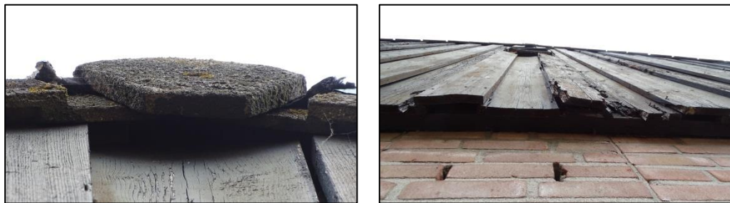
Toegang tot dakbeschot en ruimtes achter gevelbetimmering.
