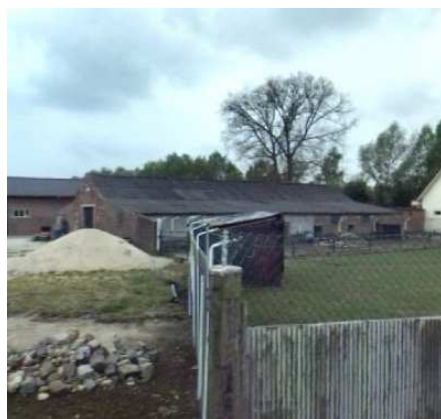
Te slopen schuur Holtpasweg 7 te Beek (287 m 2 )
