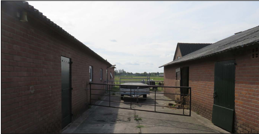
Figuur: voormalige zeugenstallen. De muren zijn van bakstenen en betreffen spouwmuren. De daken zijn gemaakt van (asbest)golfplaten.
