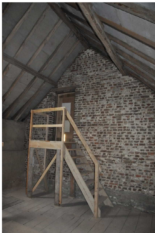
40. Bouwmuur op de zolder tussen hoofdboord en woonhuis, gebouwd omstreeks 1891 bij het dichtmaken van de voorgevel en derhalve uitgevoerd in slordig metselwerk.
