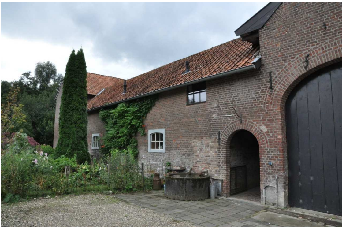
16. Buitengevel van de rechterzijvleugel.
