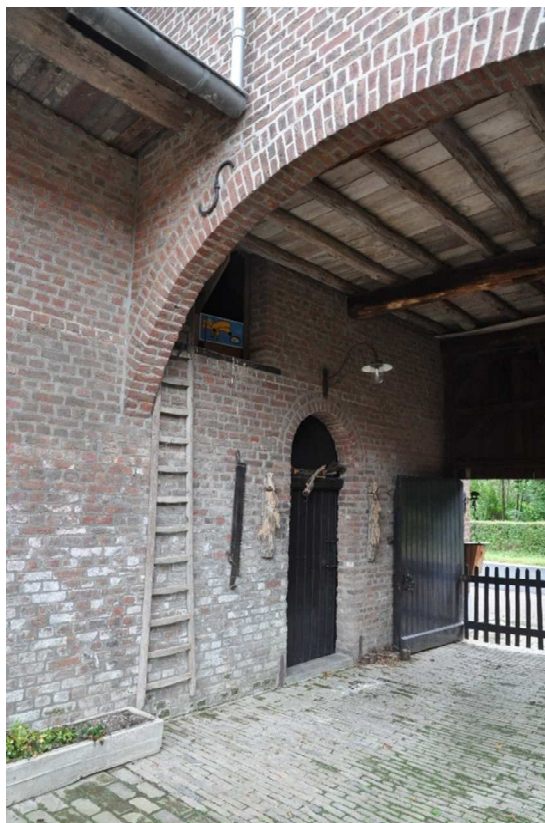
26. De binnenplaatsgevel gezien naar de hoofdpoot aan de straatzijde.
