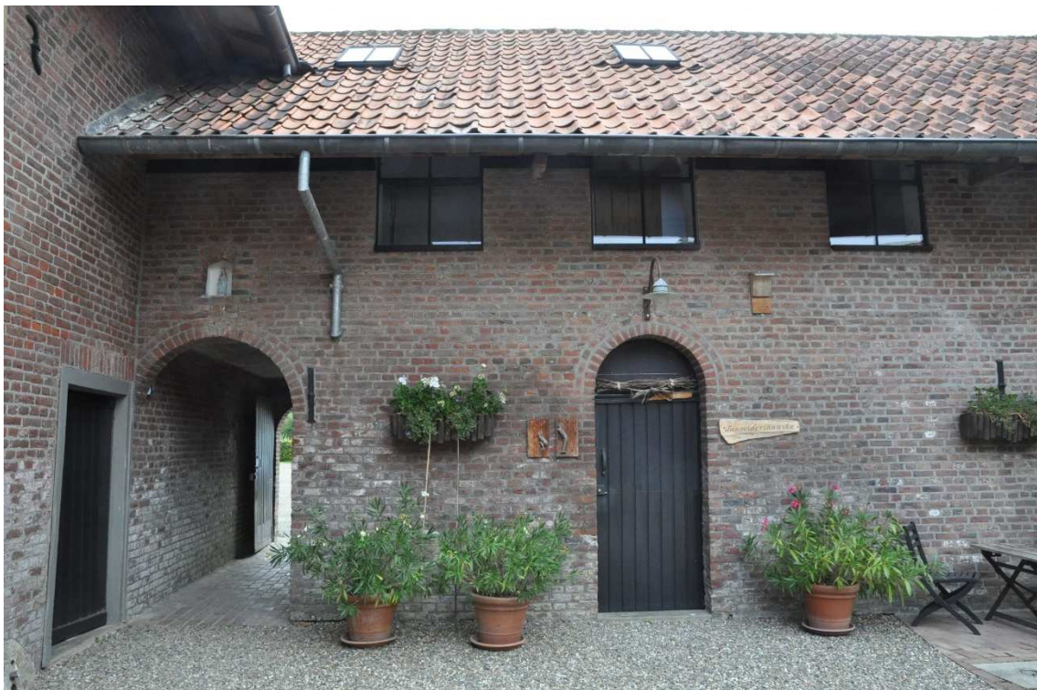
28. Binnenplaatsgevel bij de onderdoorgang naast de schuur.
