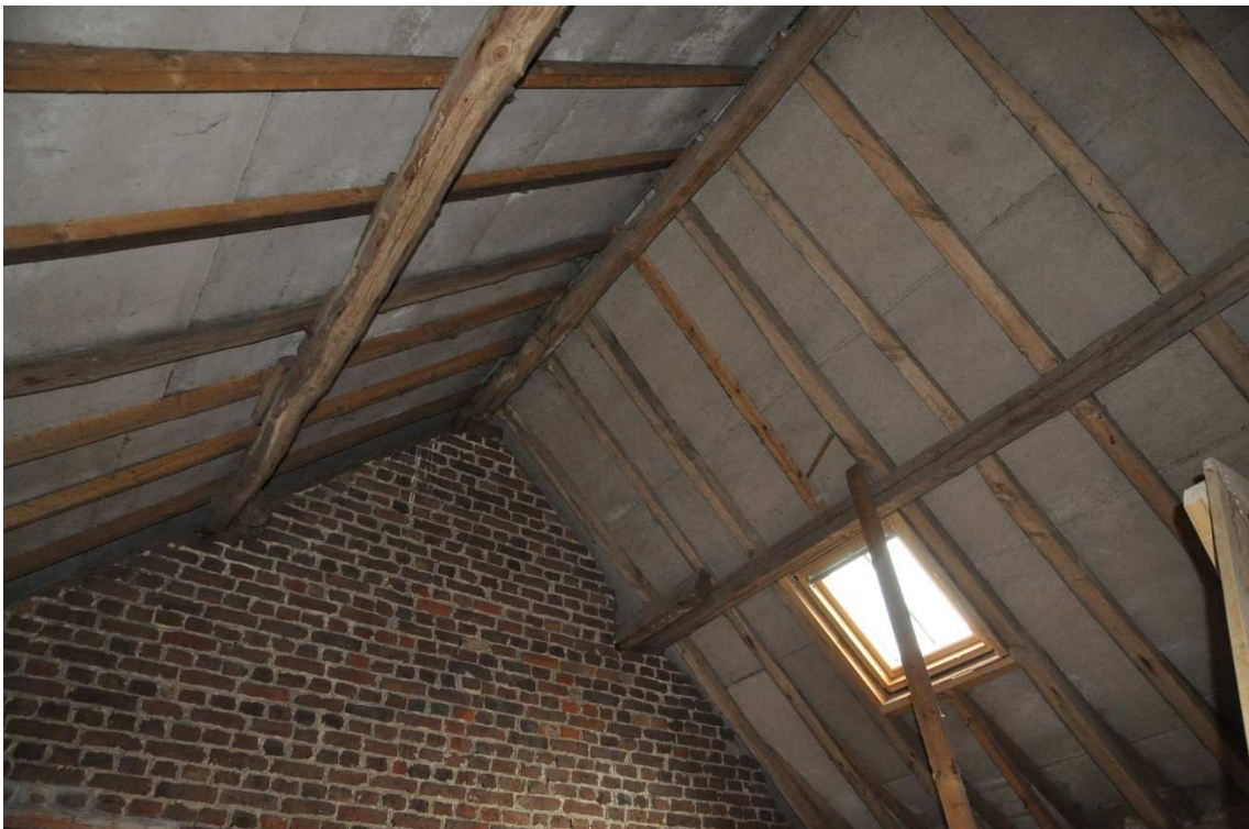
32. Dakconstructie boven de onderdoorgang bij de hoofdboort.
