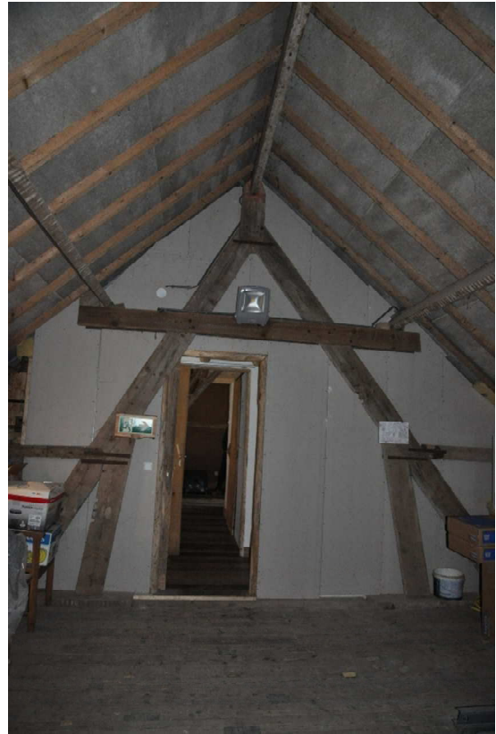
37. Later aangebracht spant in het midden van de zolderverdieping.
