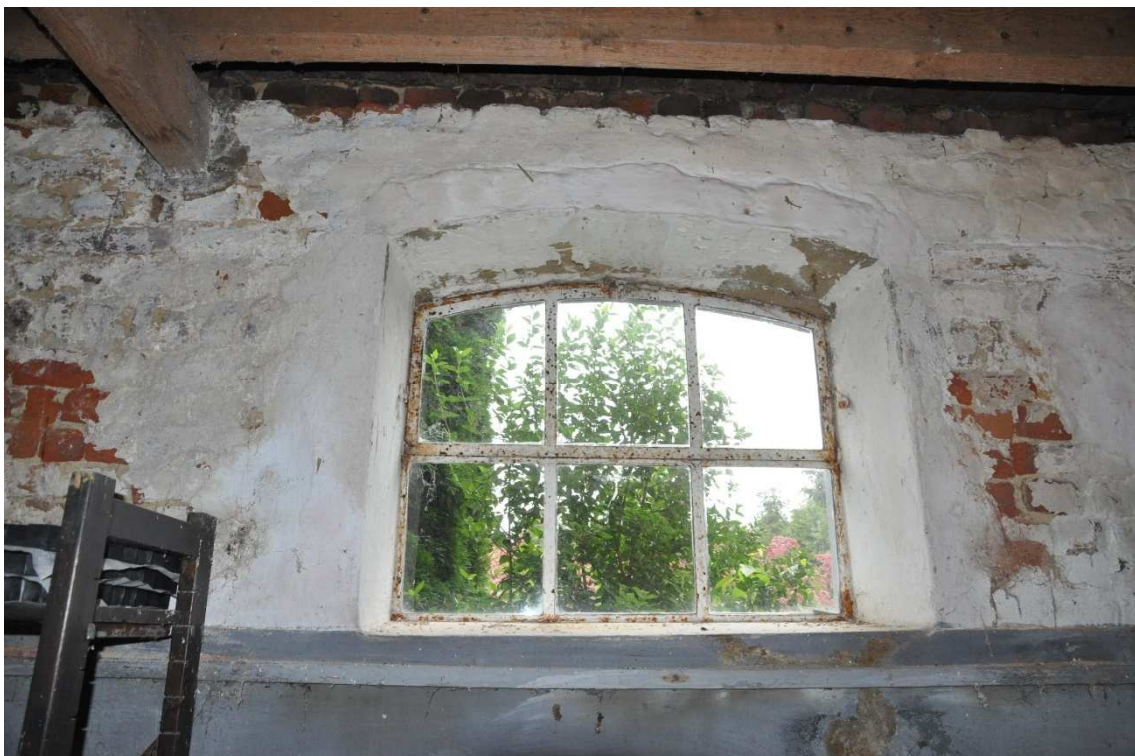
24. Stalraam in de zijgevel gezien vanuit het interieur. Linksboven een later aangebrachte moerbalk uit gezaagd naaldhout.
