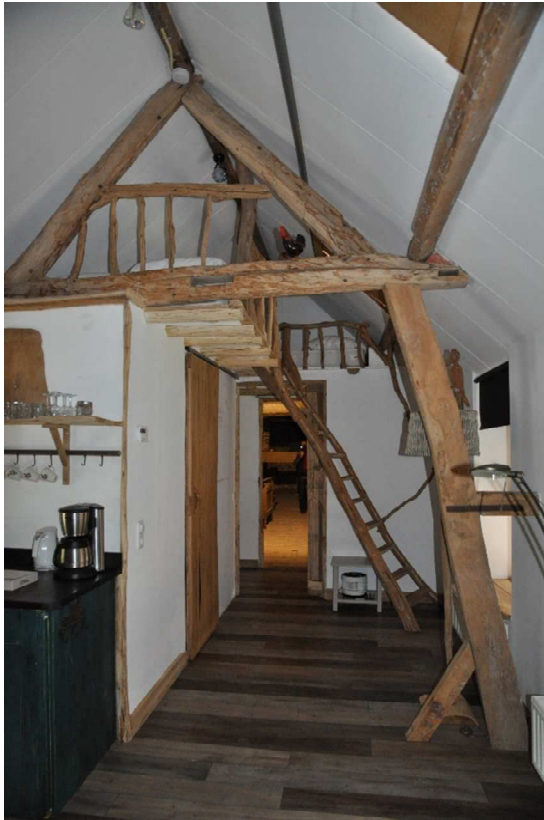
36. Nieuw aangebracht gastenverblijf op de zolderverdieping met oud spant samengesteld uit onderdelen van een oudere vakwerkconstructie.
