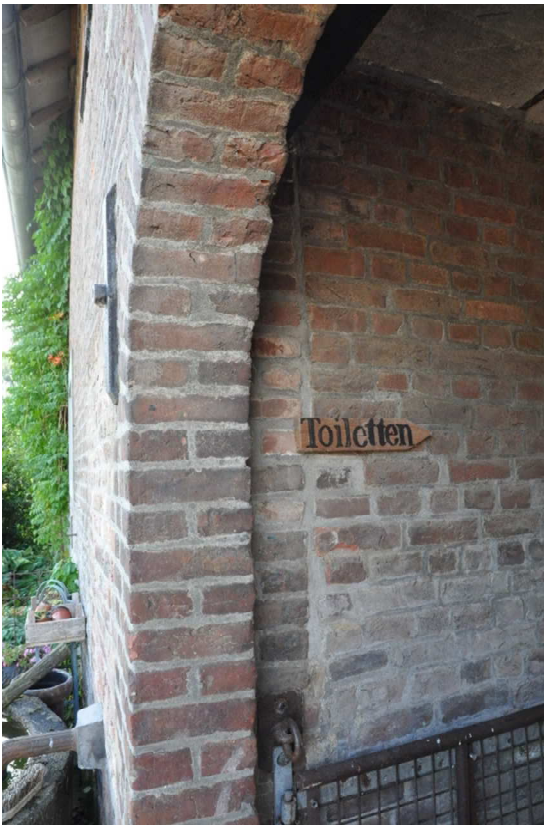
22. Bouwnaad bij de onderdoorgang in de zijgevel.
