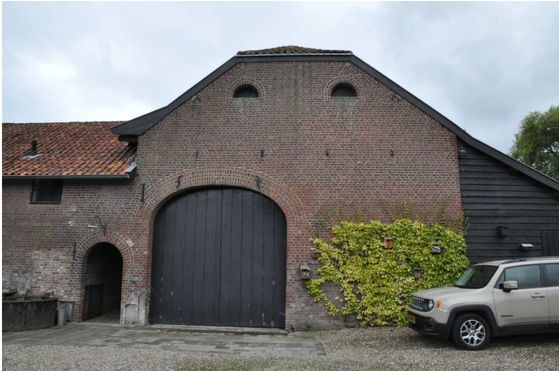
15. Oostelijke kopgevel van de schuur met onderdoorgang tussen schuur en rechterzijvleugel.
