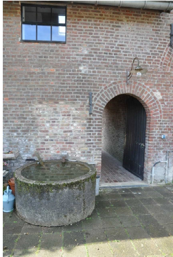
21. Onderdoorgang in de zijgevel met daarnaast een dichtgemetselde deuropening en nieuw raam onder de dakvoet.
