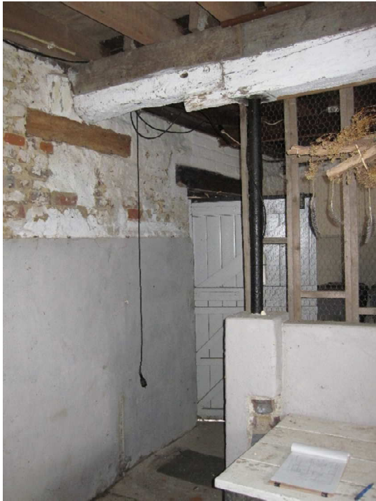
33. Laag stenen muurtje met stalen kolom onder een oude zolderbalk die is opgelegd op een in de zijgevel ingewerkte houten slof.
