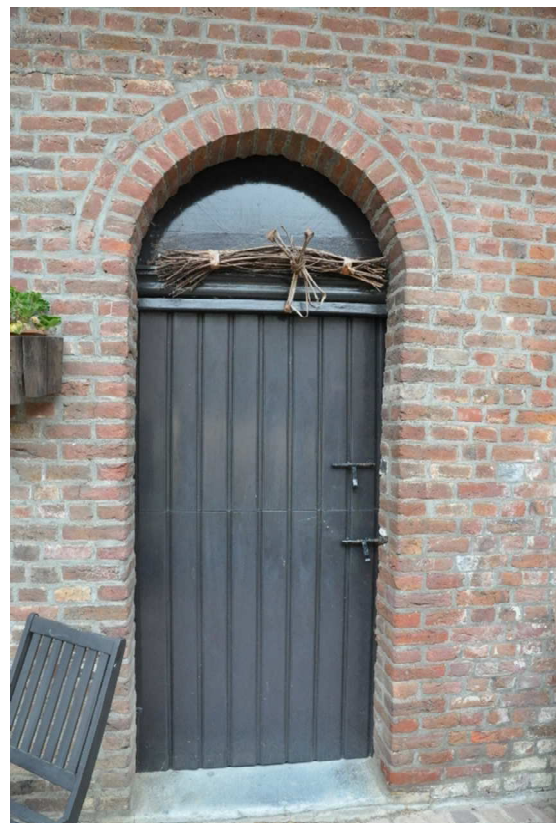
27. Een van de boerenstaldeuren met rondboog.
