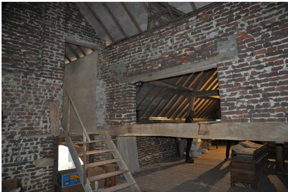
39. Aansluiting van de opengewerkte constructie op de hoofdboordoorgang gezien vanuit de binnenzijde. Nieuwe deuropening met trap. Daaronder een oorspronkelijke opening, waarschijnlijk hooiluik.
