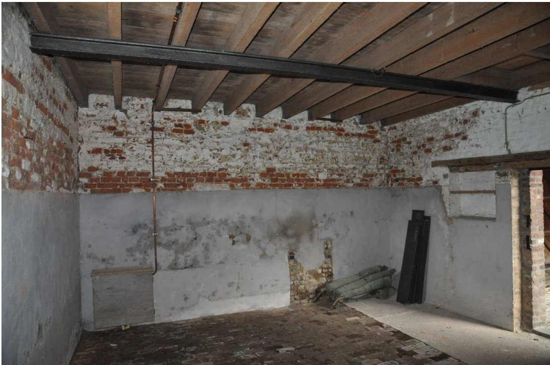
35. Ruimte aan de straatzijde met stalen rails als vloerbalk.
