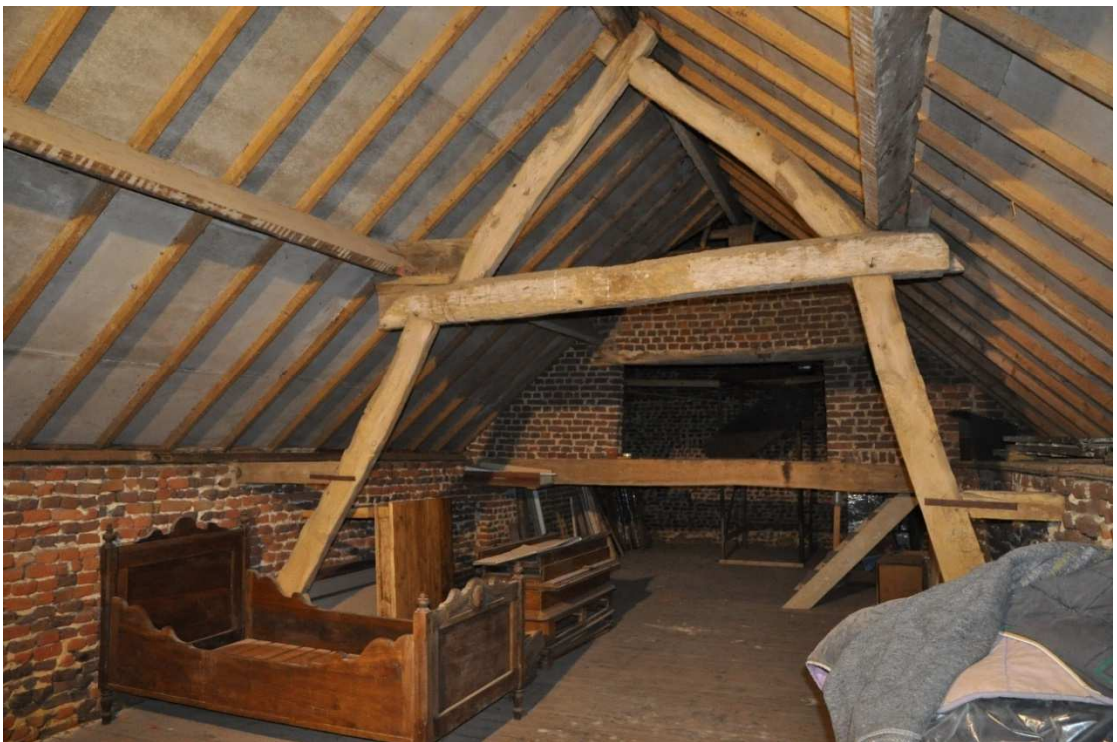
38. Oud spant met telmerk XI. Daarachter de opengewerkte constructie met schoon metselwerk op eiken balken.
