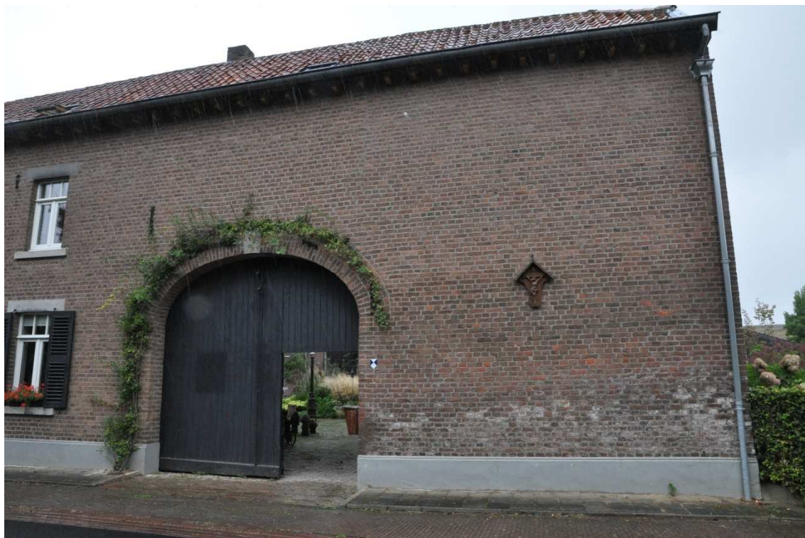
17. Voorgevel van de rechterzijvleugel.
