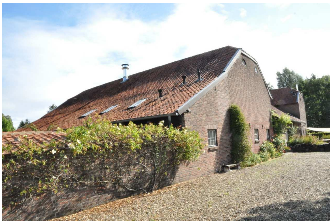
14. Aanzicht vanaf het achterterrein met zicht op de schuur aan de achterzijde, de linkerzijvleugel en westzijde van het woonhuis aan de straatzijde.
