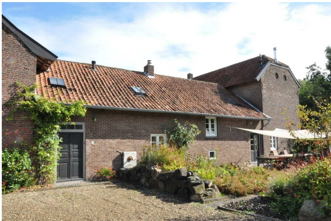
13. Buitengevel van de linkerzijvleugel en kopgevel van het woongedeelte.
