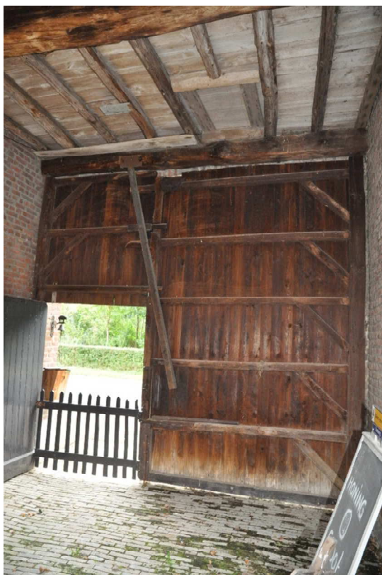
29. Hoofdboort gezien vanuit de binnenzijde.
