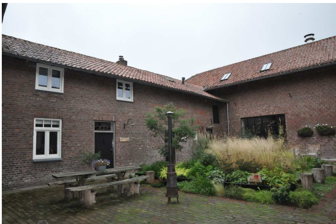
12. Binnenplaats gezien naar de verbouwde linkerzijvleugel en schuur.
