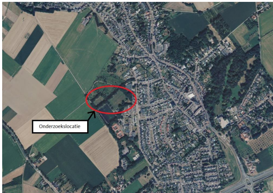
Figuur 2.2: Luchtfoto onderzoekslocatie (bron: Street Smart 2020)
