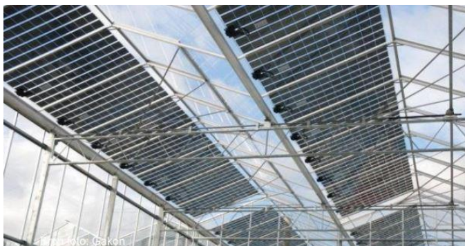
Figuur 7 Foto transparante zonnecellen op een kas, bron: InnoAgro
