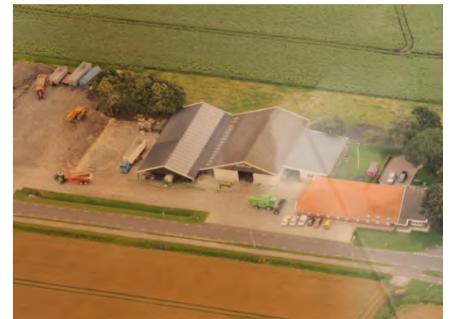
luchtfoto huidige situatie
