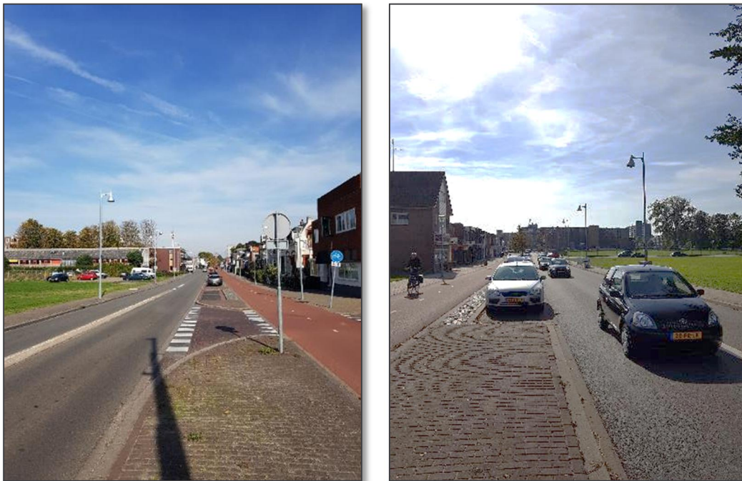
Figuur 3.4 Kerkstraat ten noorden (links) en ten zuiden (rechts) van de spoorwegovergang
