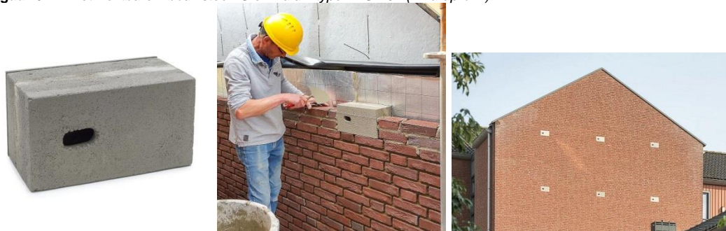
Figuur 7 Zichtbare inbouwsteen Gierzwaluw type IB GZ 02 met voorbeeld hoe het in de gevel ingebouwd wordt (vivarapro.nl).
