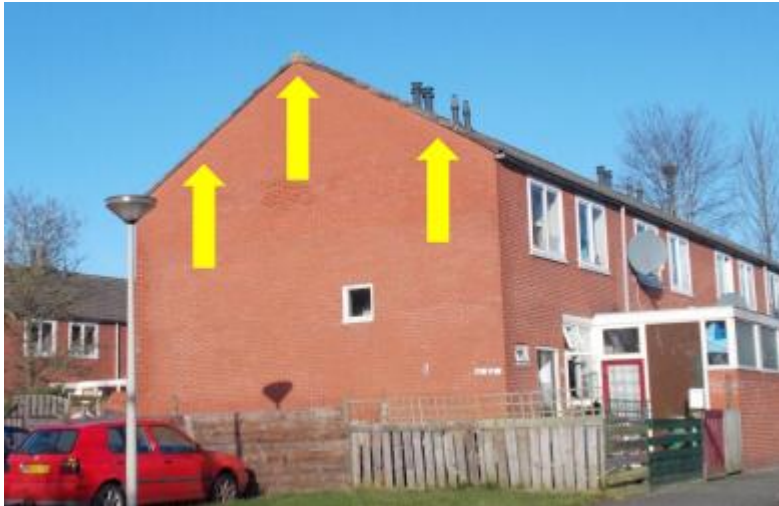
Foto 4 Voorbeeld van de invliegmogelijkheden voor vleermuizen aan de kopse kant van één van de te slopen blokken
