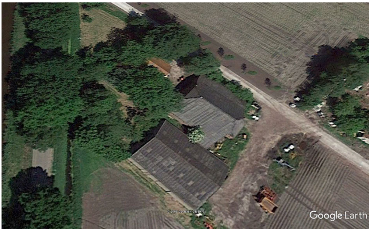
Figuur 1 Kanaaldijk Oostzijde 18 Bellingwolde. Met rood dak een woonhuis, met grijze daken de twee schuren.
