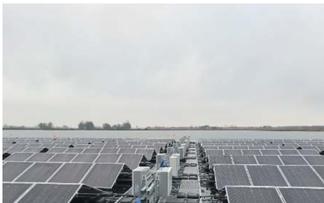
Figuur 2.5: foto 'omvormer straat' (links) en transformator in module (rechts)
