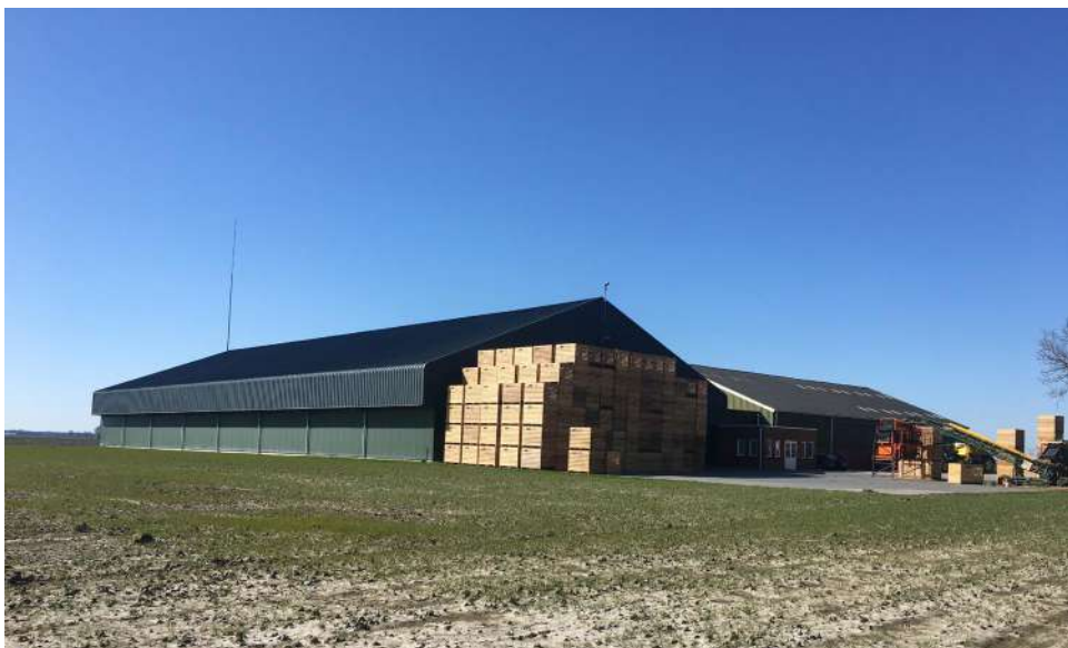
Recent gebouwde aardappelloods, Dijkwal 1
