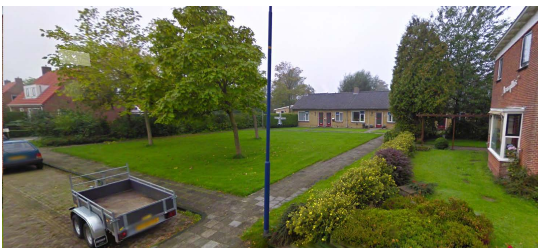
Figuur 2.4 Aanzicht bestaande situatie Molepaed
