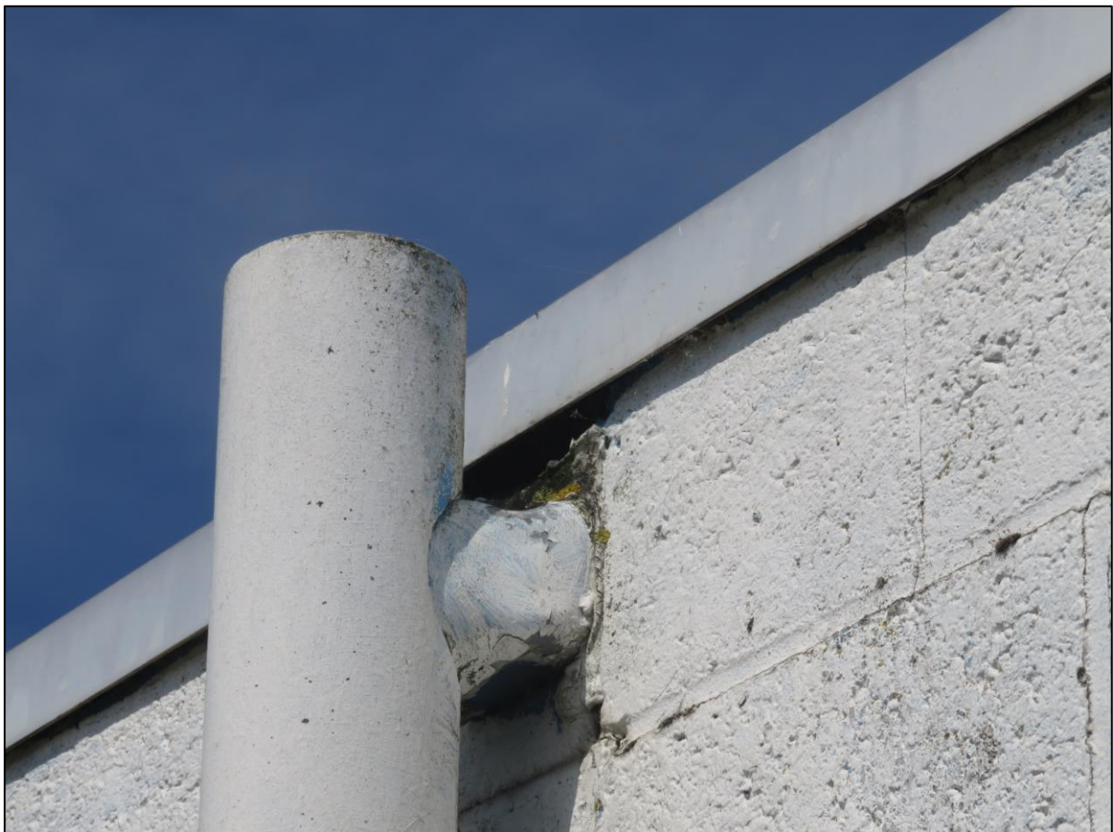
Figuur 2.3. Een potentiële doorgang tot een verblijfplaats van vleermuizen binnen het plangebied.
