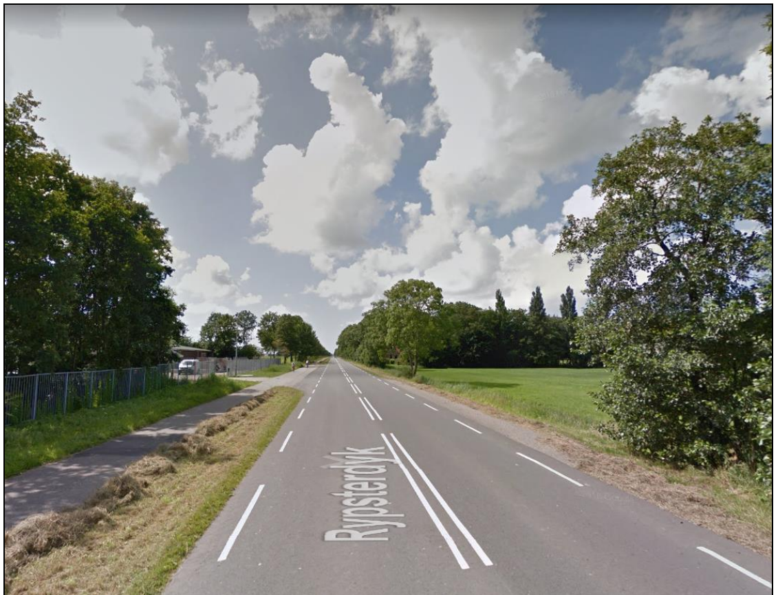
Huidige situatie Rypsterdyk met links inrit terrein (bron: Google Maps)
