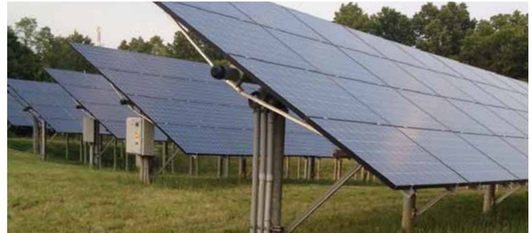
referentiebeeld onderstel zonnepanelen van gegalvaniseerd staal
