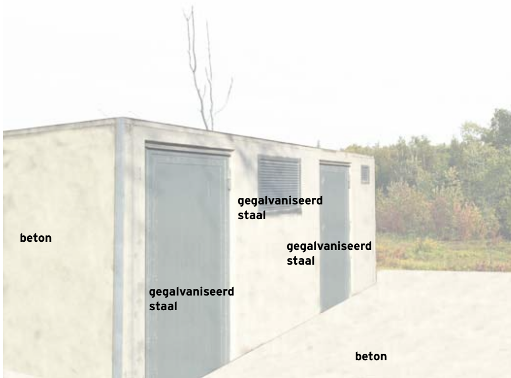
referentiebeeld trafo/inverterhuisje van beton met gegalvaniseerd stalen deuren en roosters
