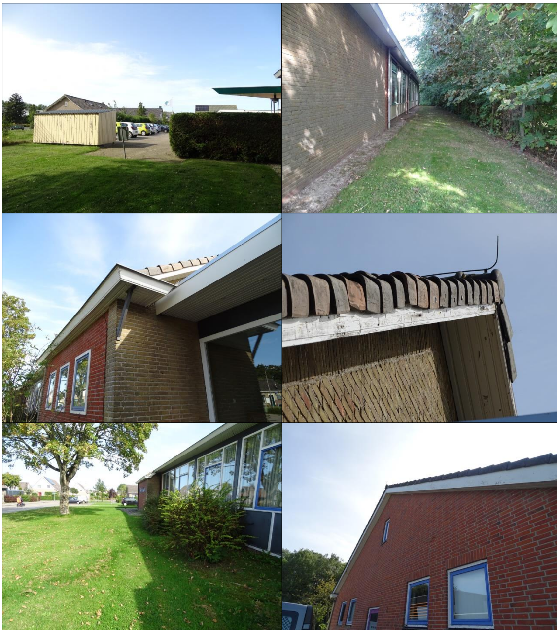
Foto's 3 - 8. Linksboven het aanzicht op de parkeerplaats vanuit het zuiden. Rechtsboven de zuidzijde van het Groene Kruis-gebouw. Links midden de noordzijde van het dorps huis. Rechts midden het pannendak van het dorps huis met ruimtes. Linksonder de noordzijde van het dorps huis. Rechtsonder de oostgevel van het dorps huis.
