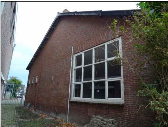
Figuur 7. Zijaanzicht van het te slopen gebouw, gezien vanaf het zuiden.
