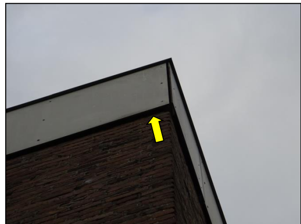
Figuur 16. Ruimte achter de betimmering aan de voormalige kerk kan fungeren als zomer- en/of paarverblijfplaats voor gebouwbewonende vleermuizen.
