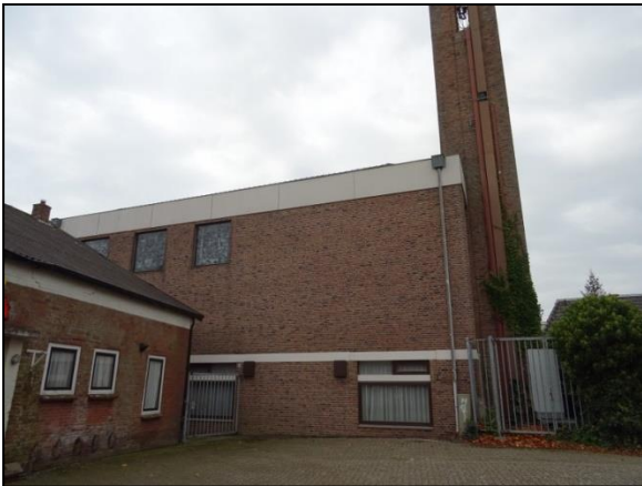
Figuur 5. Aanzicht van de voorzijde van het te slopen café (links) en de zijgevel van de voormalige kerk (rechts), gezien vanaf het noordoosten.
