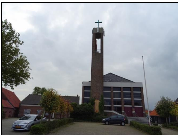
Figuur 3. Aanzicht voorkant voormalige kerk, gezien vanuit het noorden.
