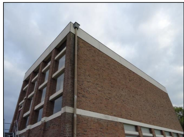
Figuur 4. Aanzicht voormalige kerk, gezien vanuit het zuidoosten.
