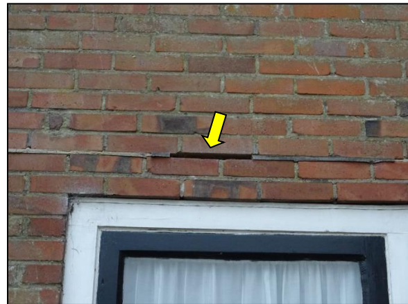
Figuur 14. Detailfoto spleet in de voorgevel van het voormalig café, welke kan dienen als zomer- en/of paarverblijfplaats voor gebouwbewonende vleermuizen.
