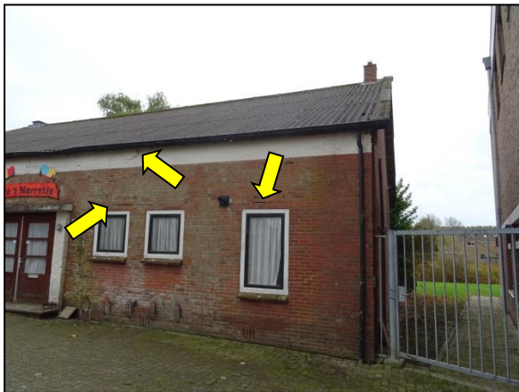
Figuur 13. Overzicht spleten en gaten in de voorgevel van het voormalig café, welke kunnen dienen als zomer- en/of paarverblijfplaats voor gebouwbewonende vleermuizen.
