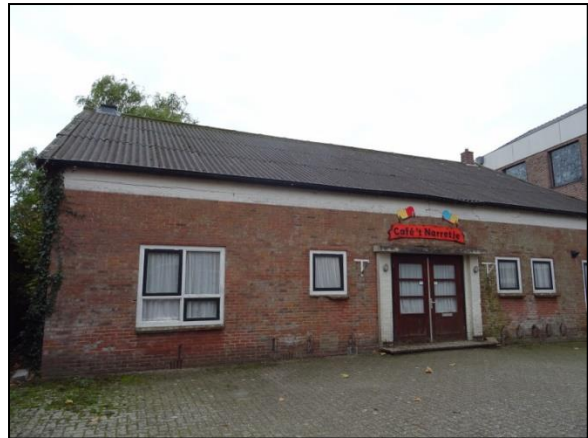
Figuur 6. Aanzicht voorgevel van het te slopen gebouw, gezien vanaf het noorden.
