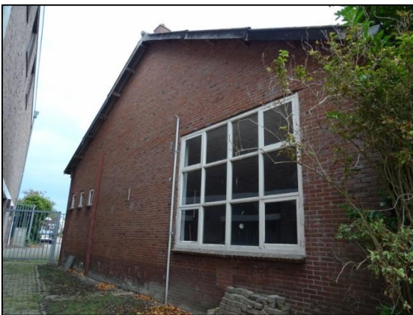
Figuur 7. Zijaanzicht van het te slopen gebouw, gezien vanaf het zuiden.
