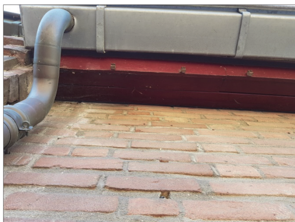
Figuur 8. Openingen achter dakbekisting
