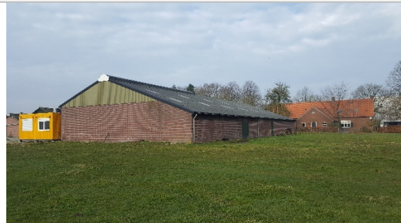
Figuur 21. Gebouw 3; foto vanuit het zuidoosten.
