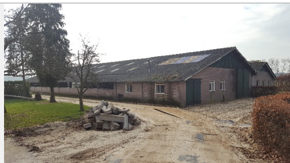
Figuur 15. Gebouw 2; foto vanuit het noorden.
