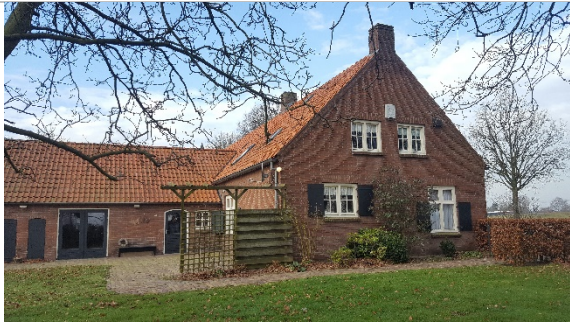
Figuur 8. Gebouw 1; foto vanuit het oosten. Eén vleermuizenkast aan de gevel aanwezig.
