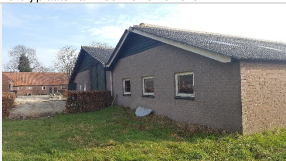
Figuur 14. Gebouw 2; foto vanuit het westen.
