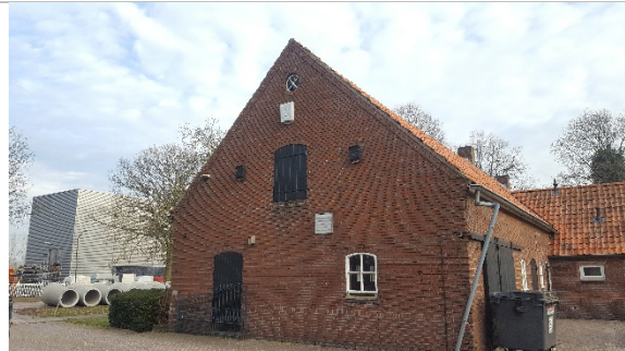
Figuur 9. Gebouw 1; foto vanuit het zuidwesten. Drie vleermuizenkasten aan de gevel aanwezig.
