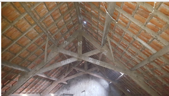
Figuur 12. Gebouw 1; binnenkant van de schuur. Openingen ter hoogte van de nok. Potentiële verblijfplaats van vleermuizen en uilen.
