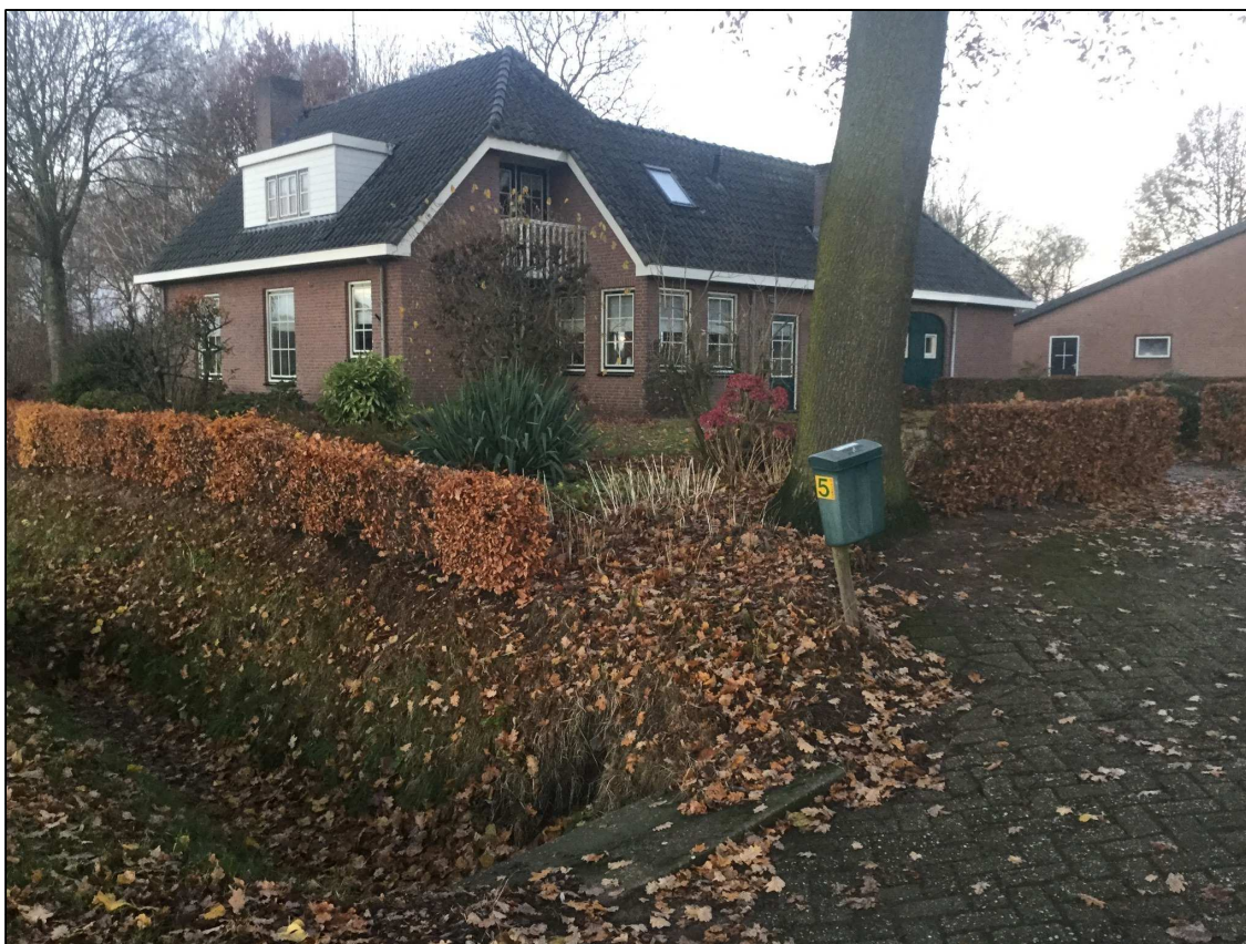
Foto 1: Woning met kapschuur op de achtergrond, richting westen
