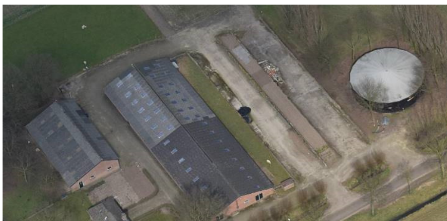
Figuur 1 ) Impressie plangebied. Het linker gebouw betreft de voormalige melkveehouderij.
