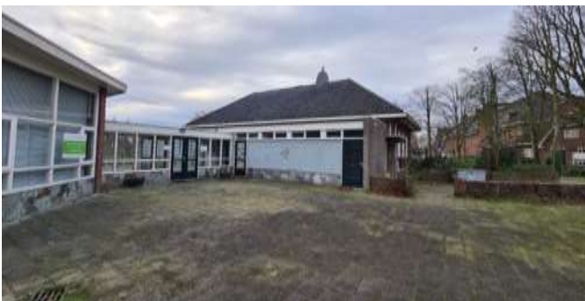
Figuur 2.3. Te slopen gedeelte en achterliggende monumentale gedeelte voormalige kleuterschool
