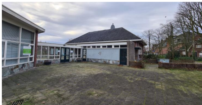
Figuur 8: Te slopen gedeelte en achterliggende monumentale gedeelte voormalige kleuterschool
