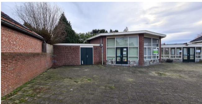
Figuur 7: Te slopen gedeelte voormalige kleuterschool
