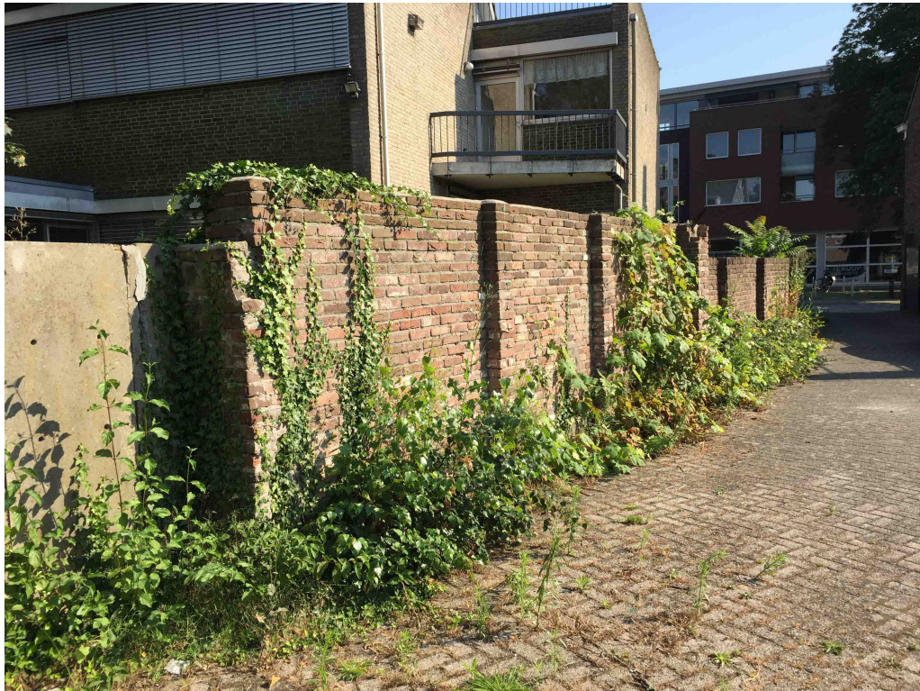
Figuur 3 De achtergelegen terreinen worden afgescheiden middels een gemetselde muur en betonnen keerwand. Het terrein is verruigd, beschermde vegetatie is niet aangetroffen.
