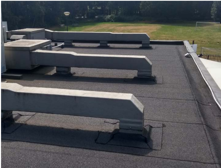
Figuur 5.1 Aanzicht buitenzijde platte dak 'Streekkamer'
