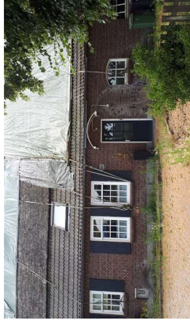
Figuur 4: Het oorspronkelijk woongedeelte met 12 ruitvensters; de luiken zijn vast aan het muurwerk verankerd; het kelderraampje heeft diefijzers. (Bron: Cultuurhistorisch advies De Horstjens Eerde, Cuijpers advies, 2019)
