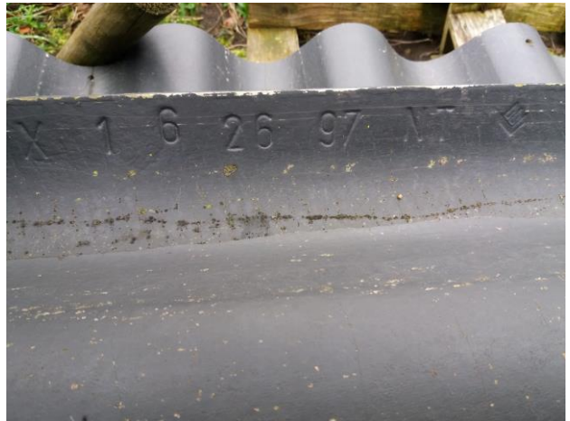
Foto 4: detail plaatmateriaal met NT-code en jaartal
