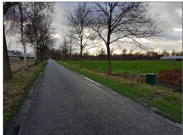
Figuur 4. Plangebied (rechts) gezien vanaf straat
