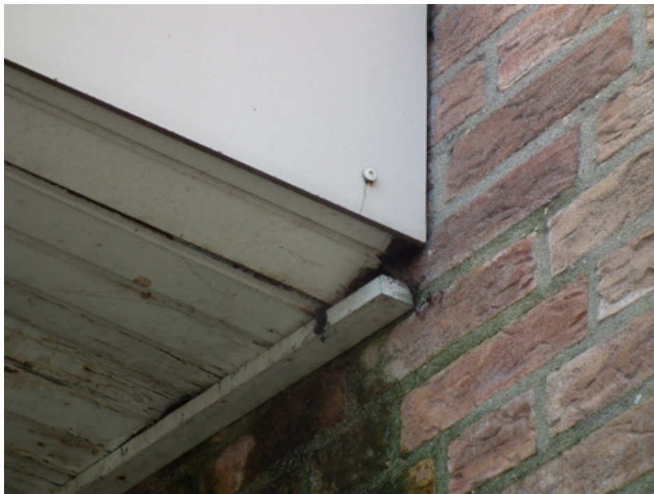
Figuur 4 Het pand is doorgaans in gebruik als kringloopwinkel, de woning is momenteel een leegstaand gebouw.
