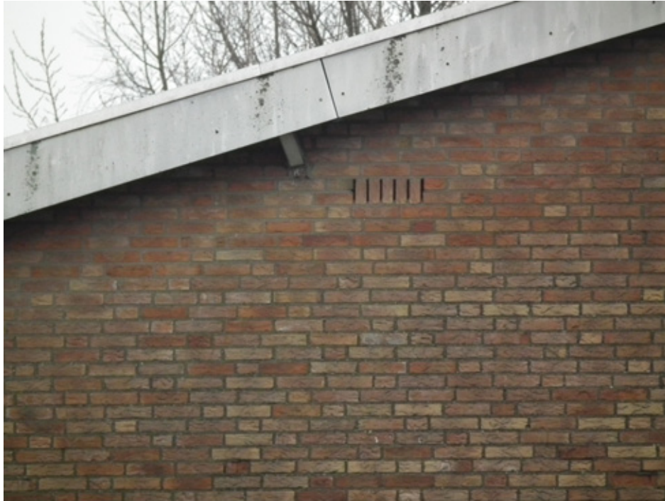
Figuur 3 De planlocatie bestaat voornamelijk uit verharding en bebouwing, op en rondom de locatie is algemene aangeplante vegetatie aanwezig.
