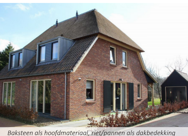
Baksteen als hoofdmateriaal, riet/pannen als dakbedekking
