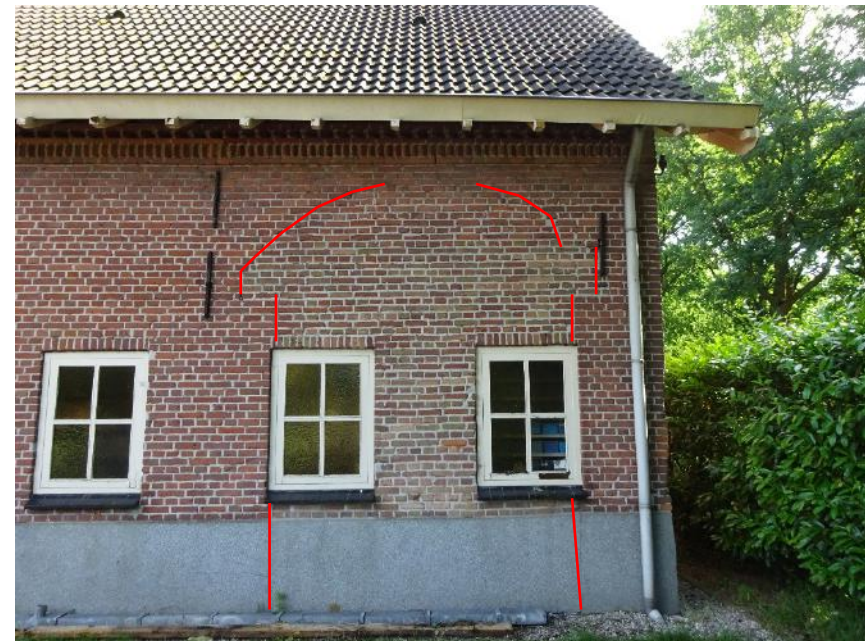
Figuur 8 - bouwspoor ter plaatse van uitgebroken getoogde poort.
