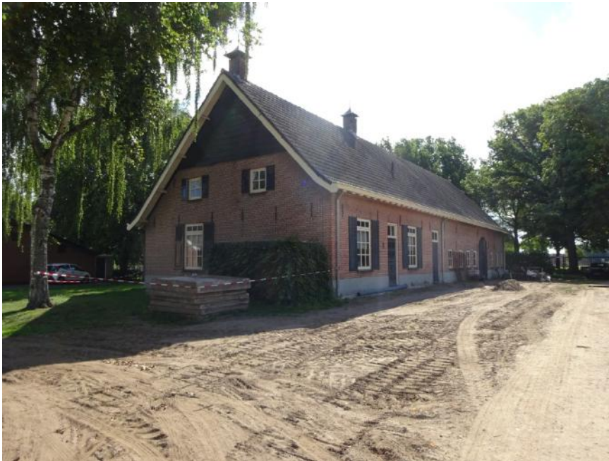
Figuur 9 - Linker zijgevel - de geveltop is voorzien van gepotdekselde planken.
