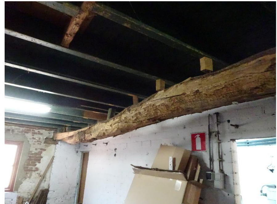
Figuur 13 - Interieur stalruimte: oude (hergebruikte en verlengde) draagbalk.
