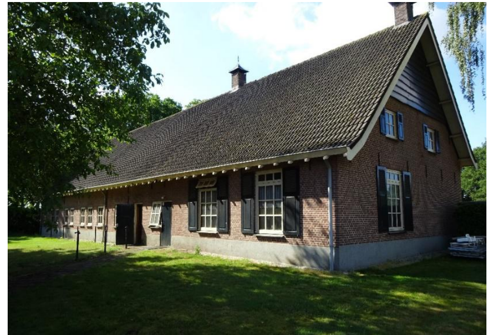
Figuur 10 - Achtergevel; het onderscheid tussen voormalig bedrijfsdeel (links) en de voormalige bedrijfswoning (rechts) is bewaard gebleven.
