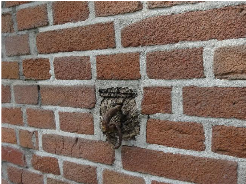
Figuur 11 - Ingemetselde houten blok met ijzeren bevestigingsring.
