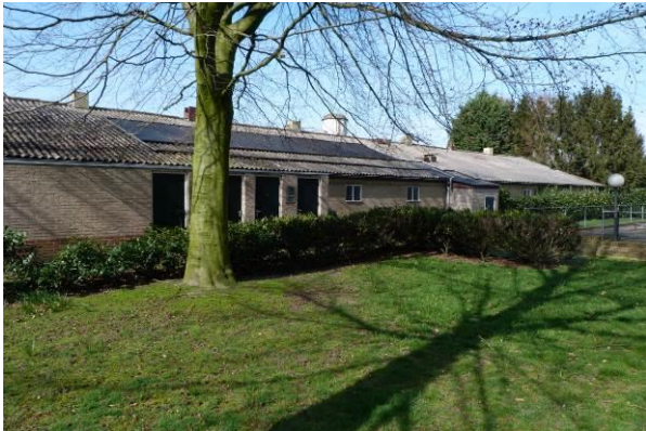
Fig 9. Te slopen bebouwing noordelijk deel plangebied
