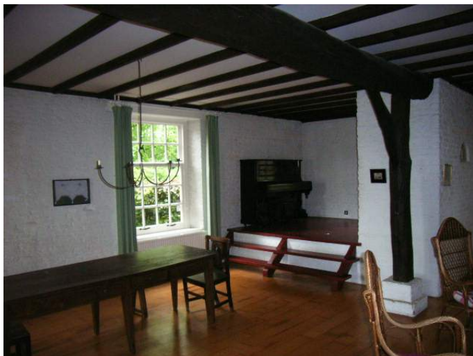
Figuur 15 - Woonkamer 2017; het achterste deel (met de piano) is de oorspronkelijke opkamer (een deel van de voorste wand is bij de restauratie in 1977 verwijderd); de toegang tot de eronder gelegen kelder is rechts achter de stoel zichtbaar; hier is een deel van het gebint met gebintstijl en korbeel zichtbaar, mogelijk hergebruikt uit de oudere, achttiende eeuwse bouw.
