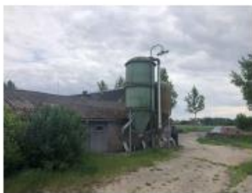
5 te slopen agrarische bebouwing met voeder silo's
