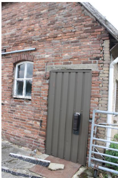
Inboetwerk bij de aansluiting met de vernieuwde voorgevel
