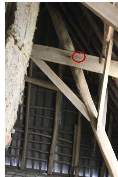
Telmerk III op een spantbeen
