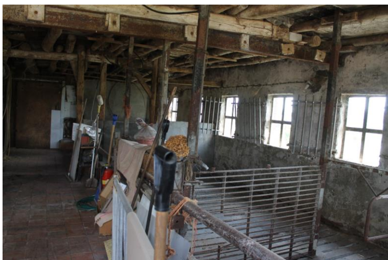
Grote stal gezien naar de voorgevel met later aangebrachte staalconstructie
