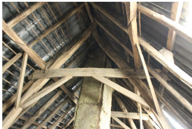
Spanten op zolder van bedrijfsgebouw
