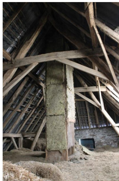
Spanten en luchtschachten
