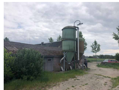
5 te slopen agrarische bebouwing met voeder silo's
