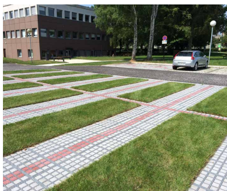
oprit waarbij rijbaan verhard en middenstrook gazon
