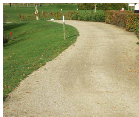
stabilizer/grind op achterterrein nabij bijgebouwen
